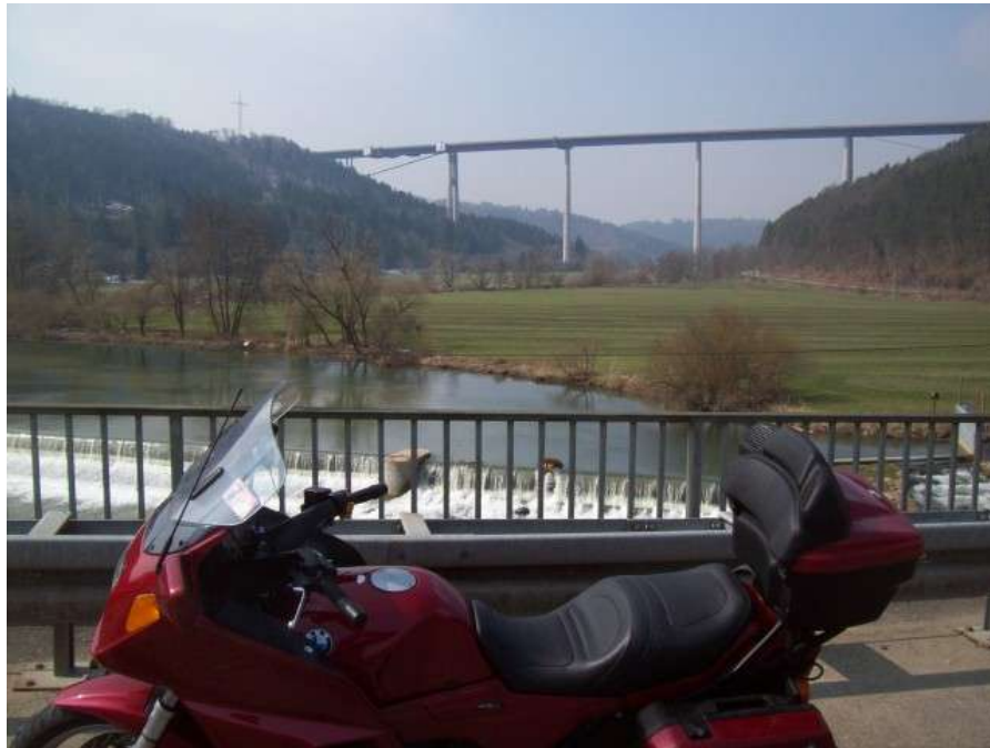
Neckarbrücke am Bahnhof Eyach. Die Weitinger Neckartalbrücke der A 81 ist 127 m hoch
