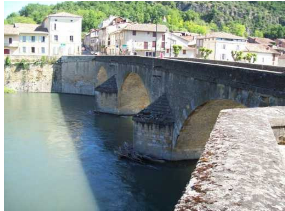
Garonnebrücke in Montsaunès
