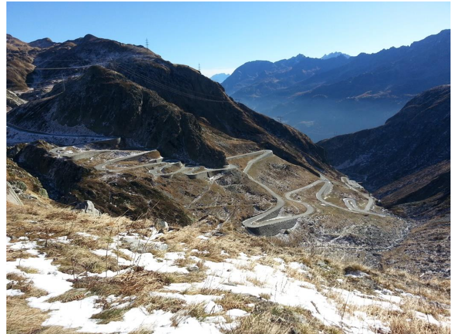
Die alte Tremola – Passstraße ist gesperrt
